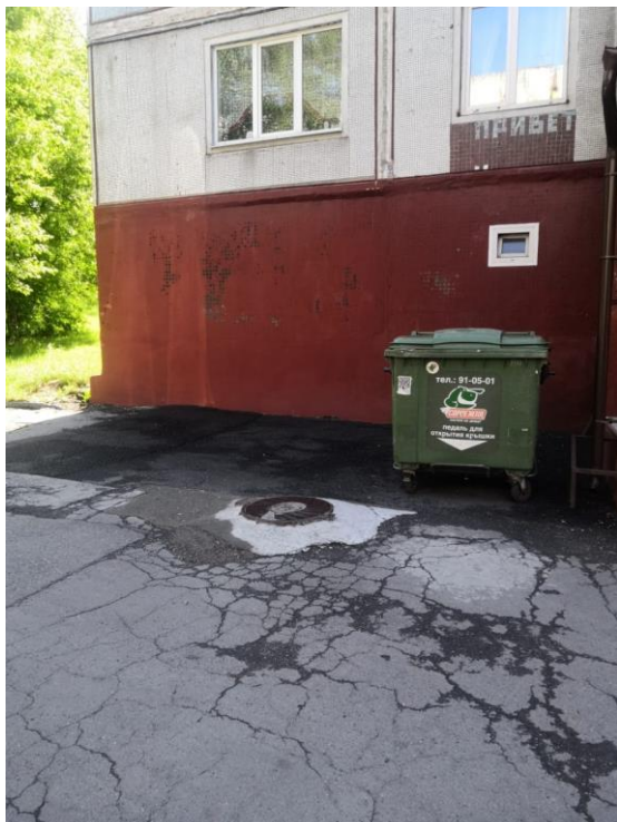
Видовой кадр 4. Состояние покрытий подходов к подъездам.
