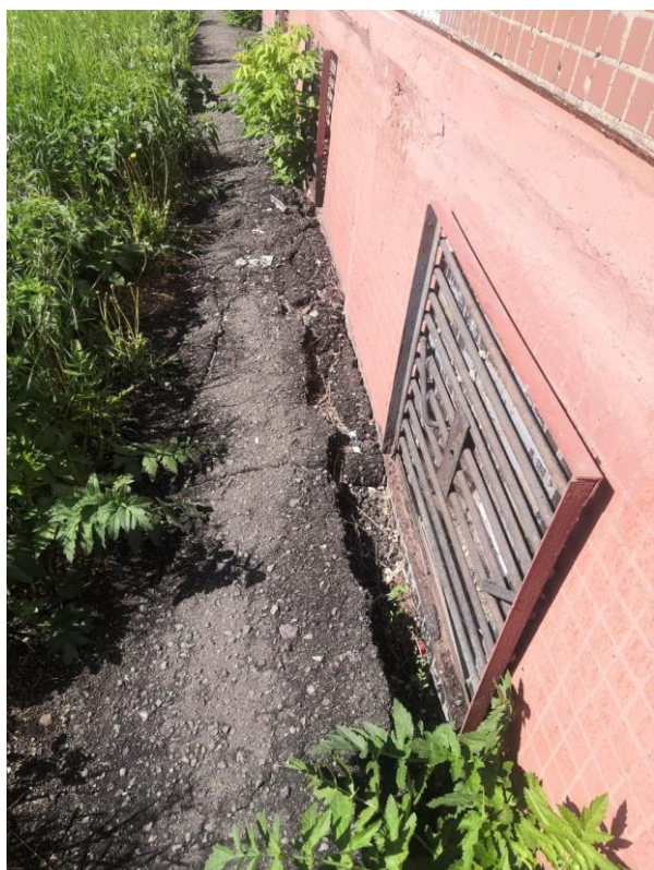
Видовой кадр 3. Состояние покрытий отмосток.
